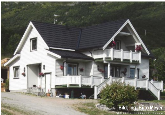
Abb. 61: Die Beschichtung einer Holzfassade kann in Teilbereichen unterschiedlichen klimatischen Einflüssen ausgesetzt sein.
