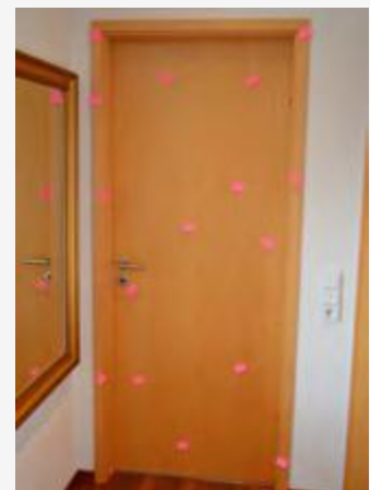
Eine solche Abnahmesituation ist nach den Regelwerken nicht zulässig. Die Markierungen sind vor der Prüfung zu entfernen.
