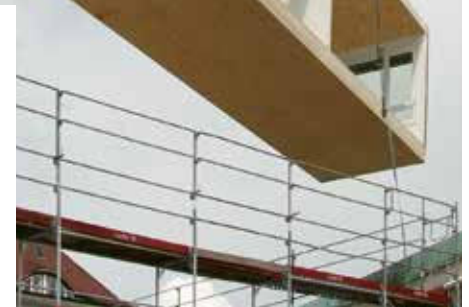
Modulbauweise, Foto rosengruen.de
